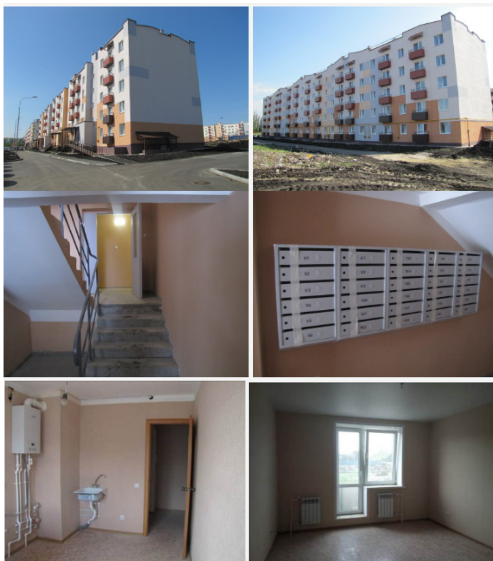
Строительство микрорайона «Заря» по этапу 2016–2017 гг. 1
